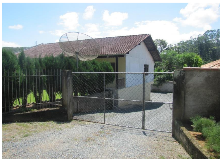
Figura 74: Residência na AID.
